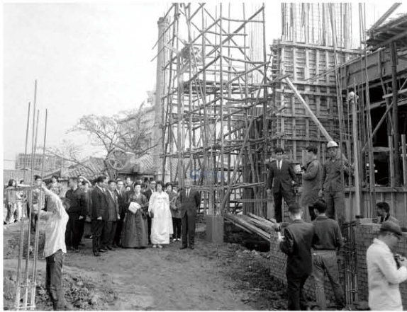
그림 31. 광주학생회관 건립공사, 1966년 현장 뒤에 1961 신축된 산업은행(구 식산은행)
